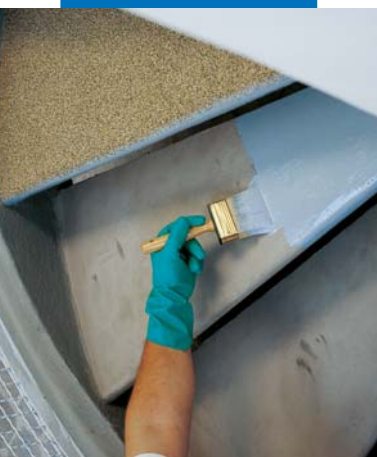
Nanošenje prvog sloja Mapecoat I 24 na beton
