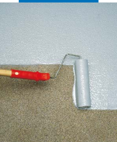
Nanošenje Mapecoat-a I 24 sa valjkom
