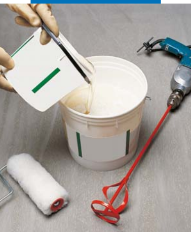
Mešanje komponente B sa komponentom A
