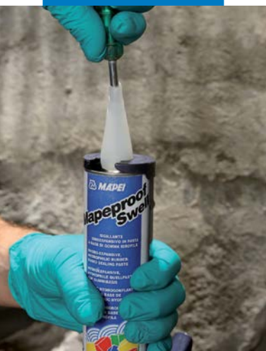
Probijanje zaštitnog dela Mapeproof Swell tube
