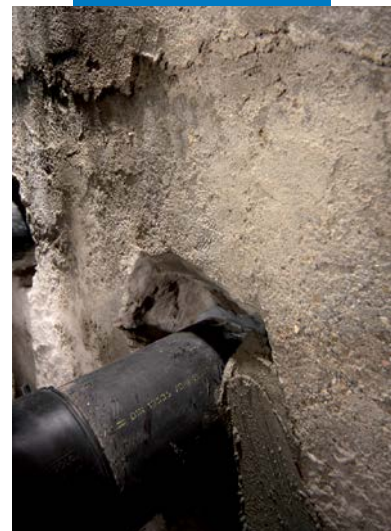
Zaptivanje Mapeproof Swell-a sa proizvodom iz Mapegrout linije
