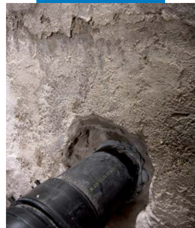
Mapeproof Swell nakon ugradnje
