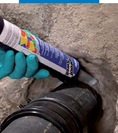
Nanošenje Mapeproof Swell-a oko cevi
