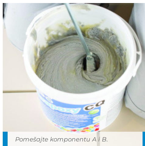
Sipajte očvršćivač (komponentu B) u posudu sa komponentom A.
