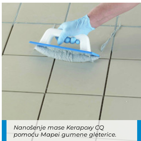
Dvokomponentna masa za fugovanje koja se isporučuje u setu koji sadrži obe komponente (A i B)
